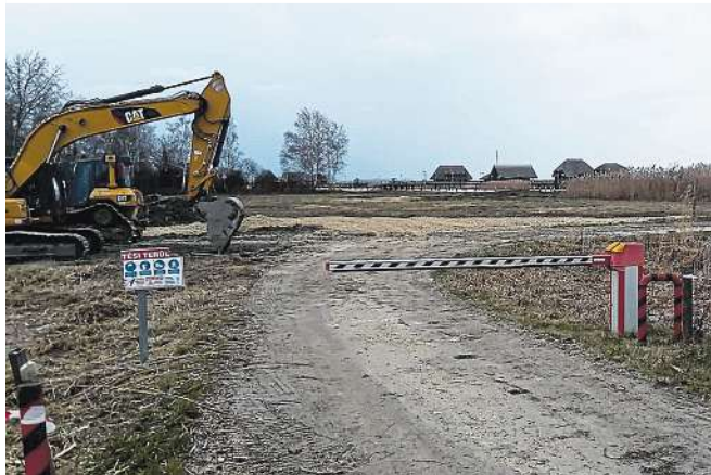
Zutritt verboten: Das Gelände wurde großräumig abgesperrt
