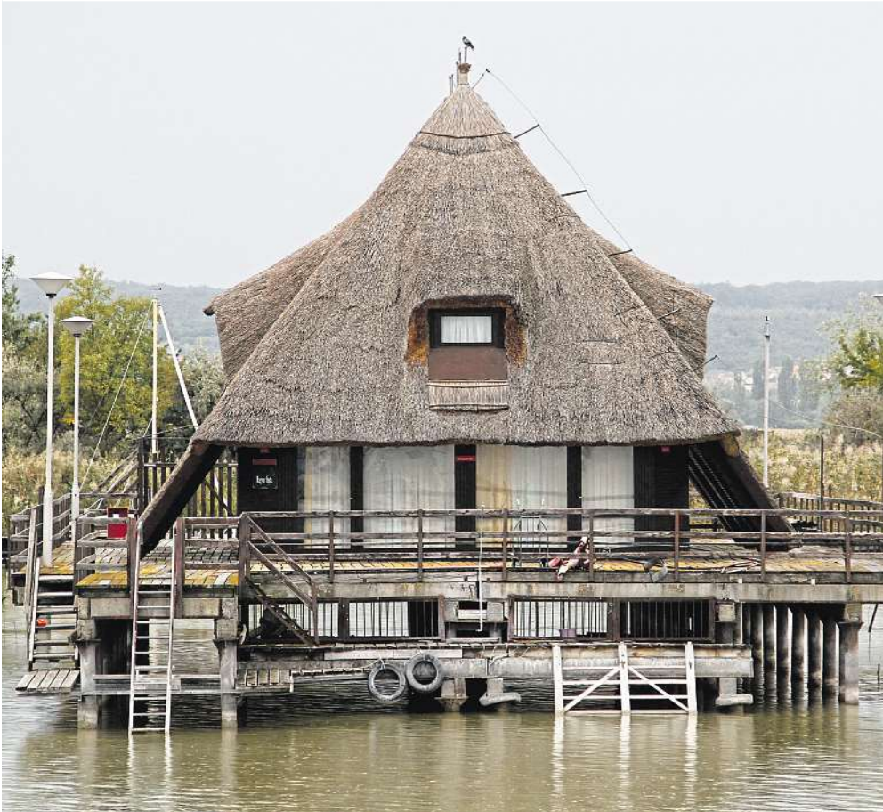
Bis Ende März müssen die Pfahlbauten entfernt werden – auf Kosten der Pächter
